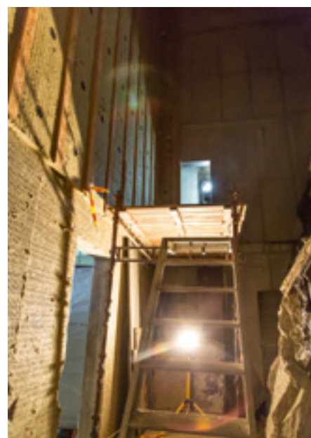
▲ Omfattende sikringsarbeid er fortatt i bakkant av den bratte tomte. Bakveggen er 16 meter høy og boltet fast i fjell.
