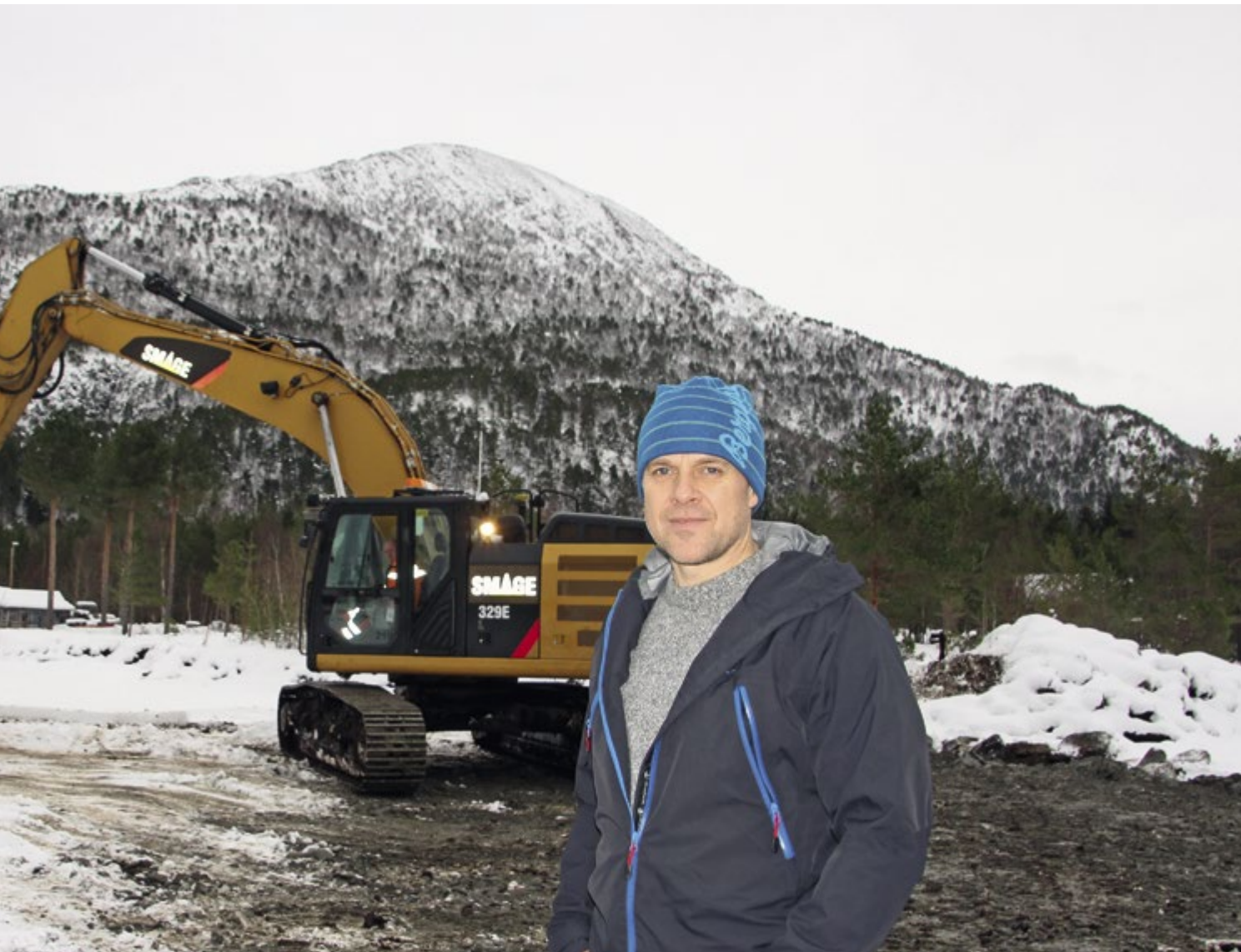
▲ Prosjektleder for Mobarn Lyngen barnehage på Jendem, Svein Ivar Byttingsvik fra MOBO, er fornøyd med at grunnarbeidet er godt i gang. I bakgrunnen gravemaskinkjører Espen Eikrem hos maskinentreprenør Odd Småge AS.
