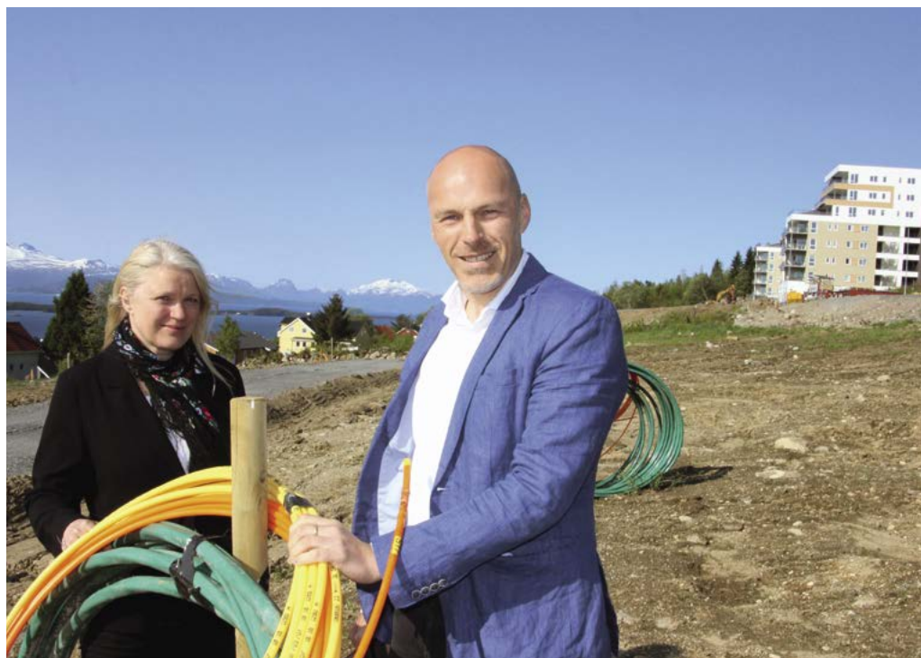
▲ Evy Strømme og Jan Egil Fornes foran en del av det nye tomtefeltet, hvor all infrastruktur nå er på plass. Til sommeren starter de første å bygge sin nye enebolig.
