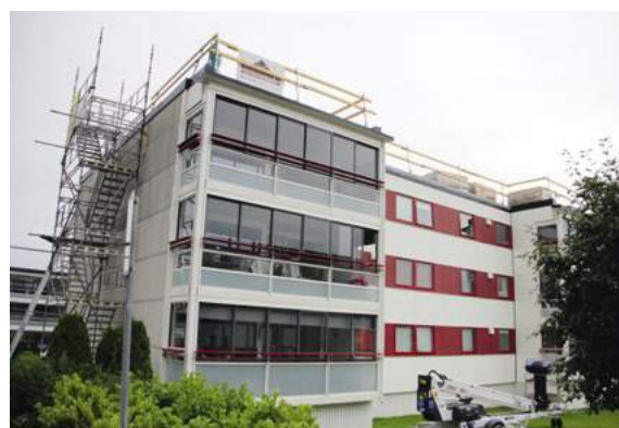
Det foregår takrehabilitering i Berg Borettslag.
