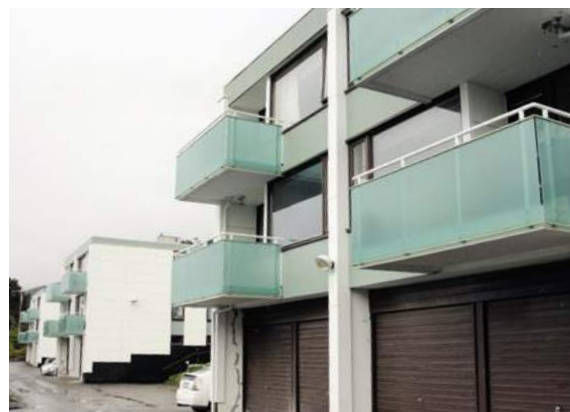
Lundabo Borettslag er snart ferdig med balkongrehabilitering.
