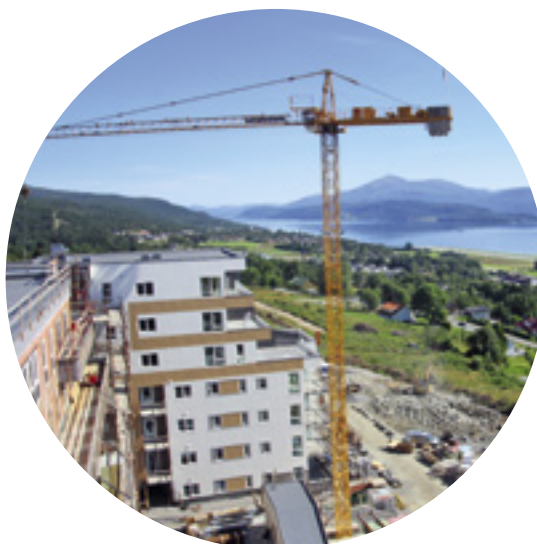
▲ Utsikt fra taket av 10. etasje i A-blokken, med blokkene B og C ved siden av.
