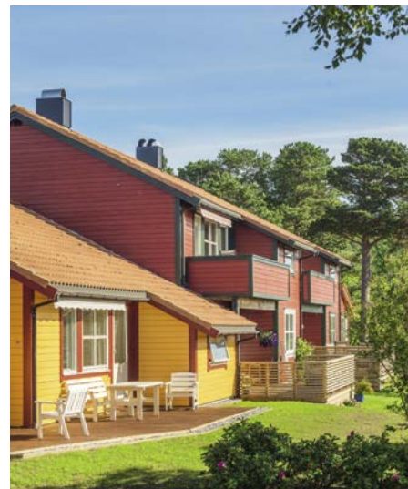
▲ I Mårskrenten Borettslag ble arbeidet med omteking av terrassene over carporter og boder ferdig i høst.
