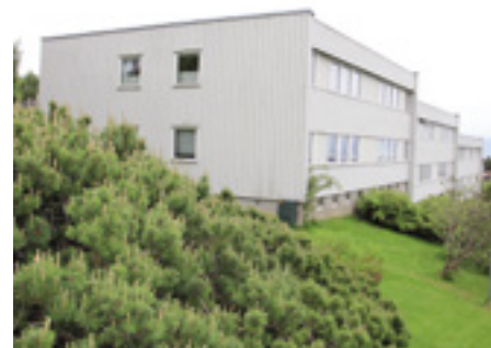
▲ Granlia 1 sett fra nordvest.
