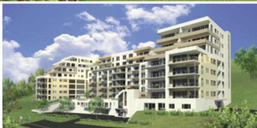
▲ Fasade sørøst med de siste endringer.
