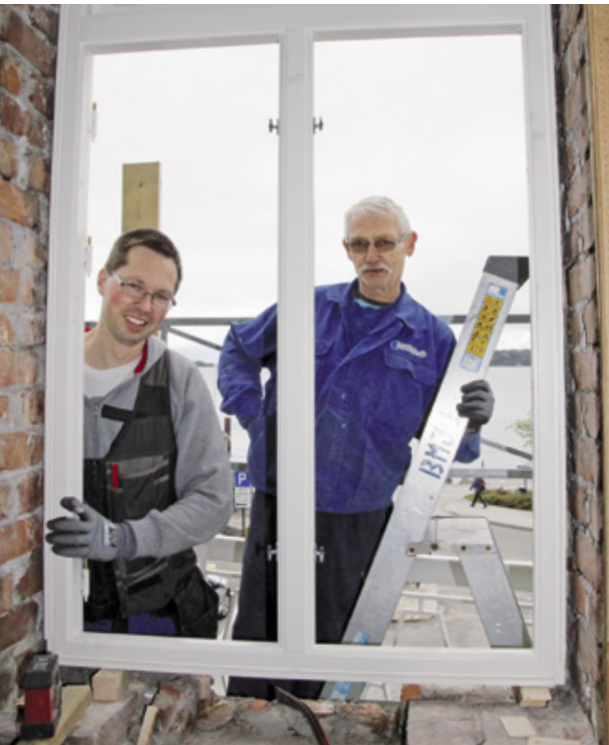
Øystein Myrnbostad og Edgeir Fransgjærde hos Ukkelberg skifter dører og vinduer i Strandgata 5, og tilbakefører bygget til et utseende likt det man hadde ved åpningen i 1917.
