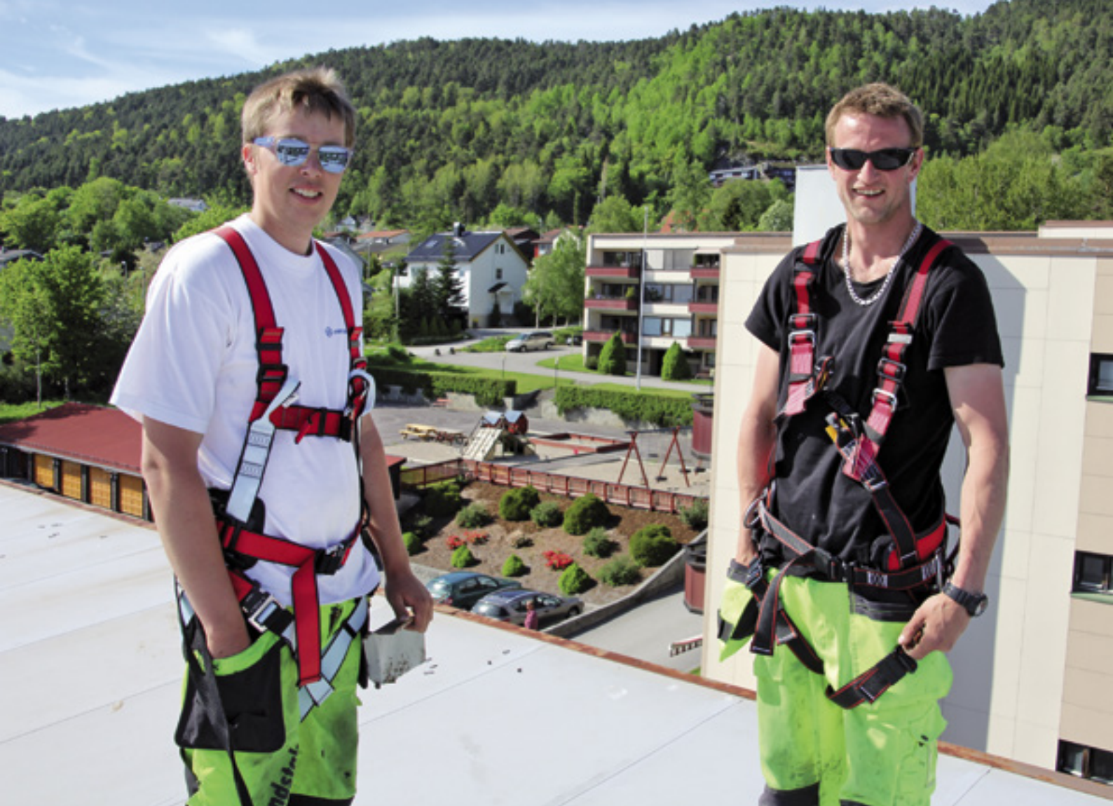
Takarbeidet i Bjørsetbo Borettslag startet i slutten av mai på den sørligste blokka. På bildet Jon Magnus Borgan (t.v.) og Per Ove Sjøstad fra Vestlandstak AS, Ålesund.
