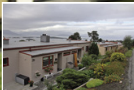
▲ Granlia 3 - Her skal alle tak etterisoleres og taktekkes.
