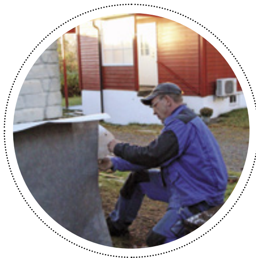
▲ Arbeidet med fasaden ble nylig påbegynt.
