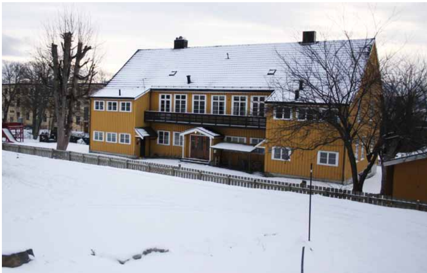
Symra: Det gamle Symra-bygget er planlagt revet og blir erstattet av en boligblokk med garasje i underetasje og tre boligitasjer.
