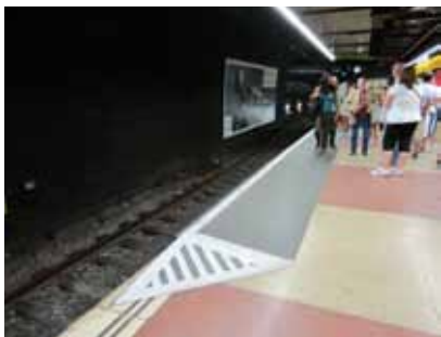
Foran på perrongen på metroen er plattformen bygd opp med tanke på rullestolbrukere (foto: NBBL/Bente Johansen).
