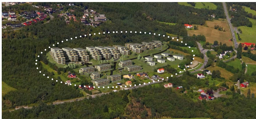
Det nye boligfeltet Eikrem Panorama innringet. Det første borettslaget kommer øverst til venstre i feltet (3 blokker)
