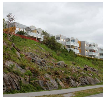
Skråningen ned mot riksvegen er ryddet og gir bedre utsyn fra boligene.
