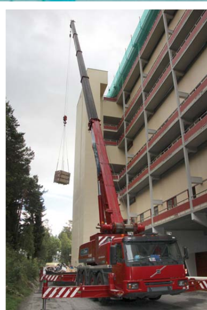
Kraftig mobilkran er i bruk for å få materialene opp i «10. etasje» i Hatlelia.
