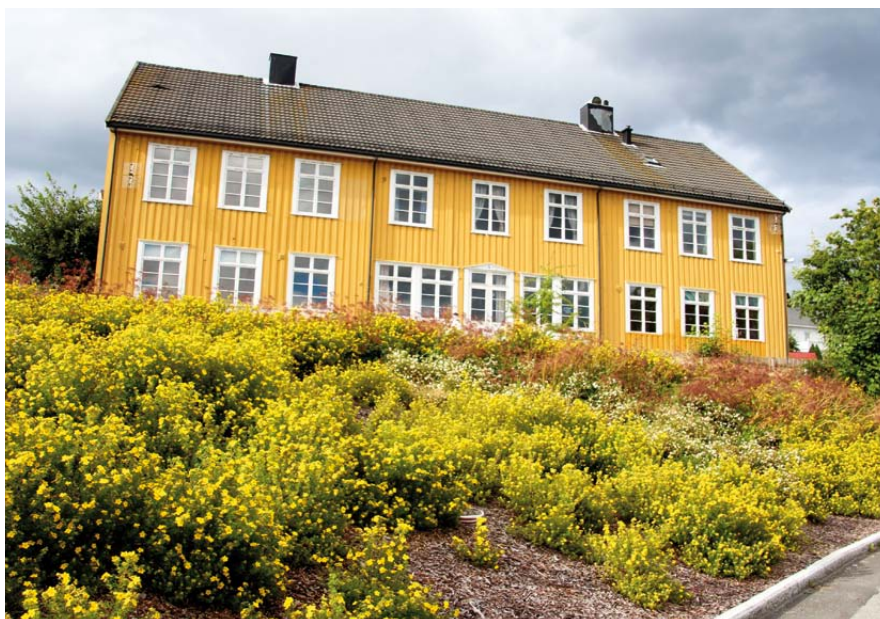
Symra barnehage er historie. Barnehagen ble stengt 15. august og skal rives for å gi plass til en lavblokk.
