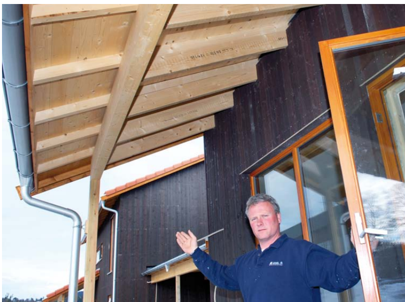
UTSPRING: Over vinduene i sydveggen er taket trukket langt ut for å skjerme mot for mye soloppvarming i varme perioder av året, forteller byggmester Per Lauritsen.
