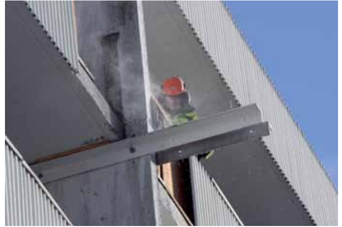
Det er mye kappearbeid for å klargjøre blokkene for nye balkonger. Her er polske Potek i arbeid.
