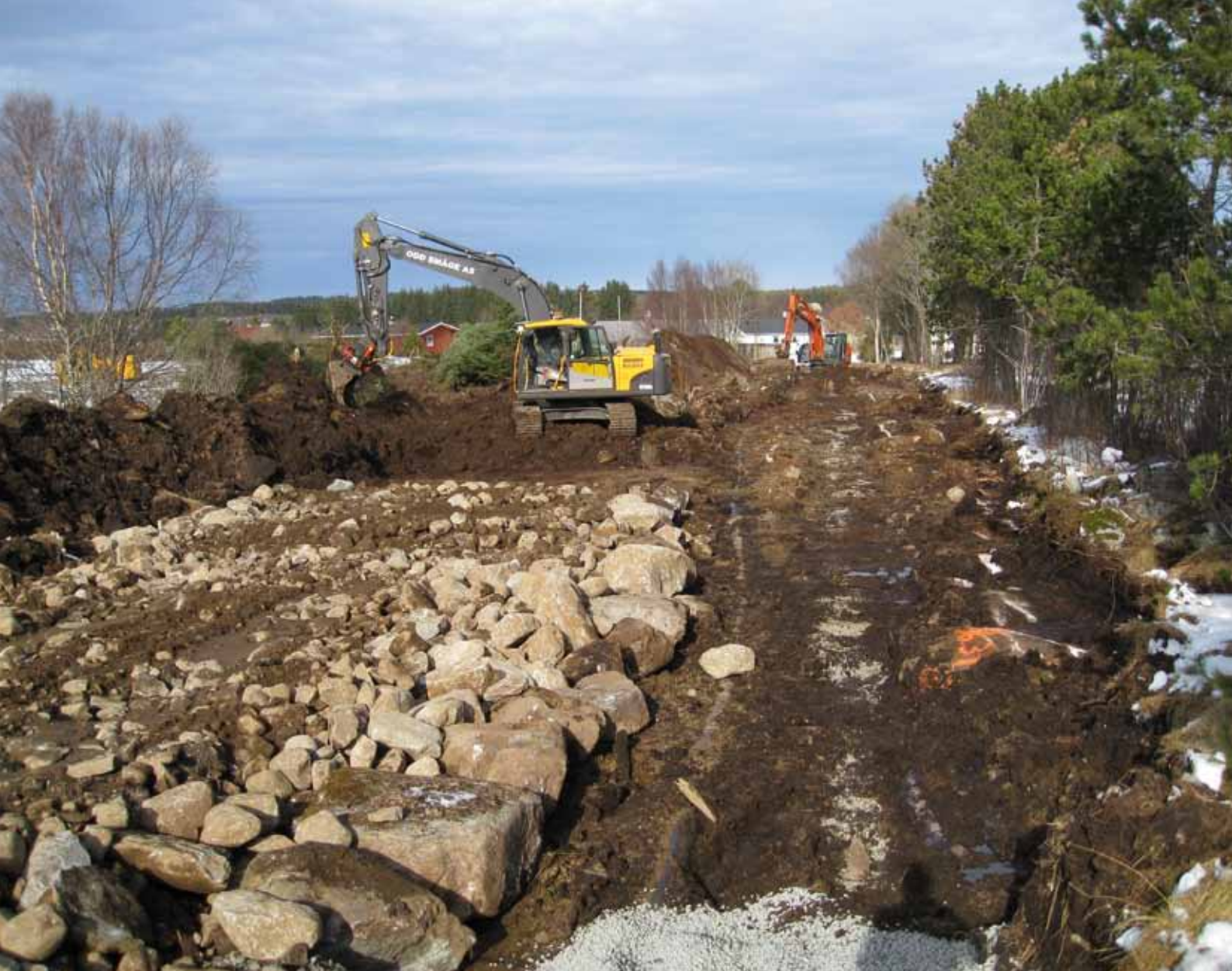
Grunnarbeidet på tomte hvor de skal bygges 12 nye utleieboliger på Falkhytten. Arbeidet utføres av entreprenør Odd Småge AS.
