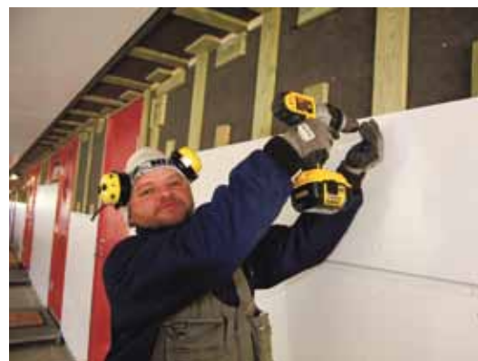
Snekker Ingebrigt Dahle hos Jan Ukkelberg AS i gang med å fullføre etterisoleringen for de aller siste leilighetene litt før påske.
