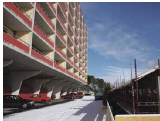
Blokka er for lengst ferdig rehabilitert, mens nordsiden av terrasseleilighetene er siste punkt i moderniseringen.
