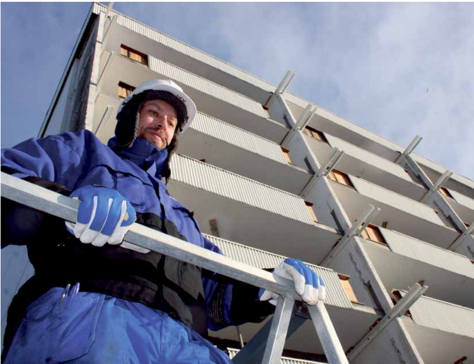
Prosjektleder Håvard Skabland i ABA-tech har full kontroll med utbyggingen av 209 innglassede balkonger i Grasåsen Borettslag.
