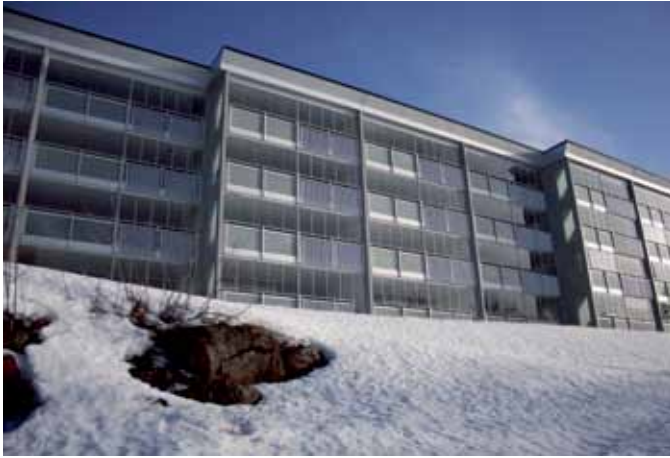
Styret i Grasåsen Borettslag hentet blant annet inspirasjon fra Skrenten Borettslag som allerede har innglassede balkonger.
