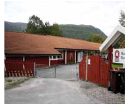
Hauglia Barnehage, byggeår 1990
