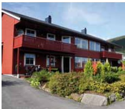
Øvre Kongefaret Borettslag, 8 leiligheter, byggeår 1998
