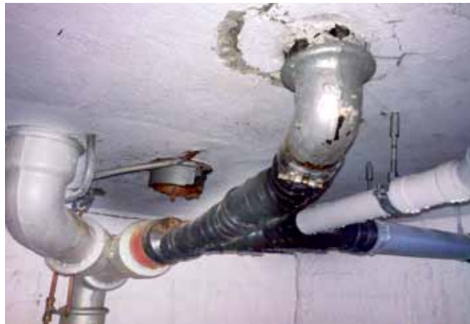
FUKTSKADER: Temperaturen må holdes over frysepunktet i boder med vannrør. Det er fort å glemme, understreker Furuheim. Bildet viser vannrør som har frosset.
