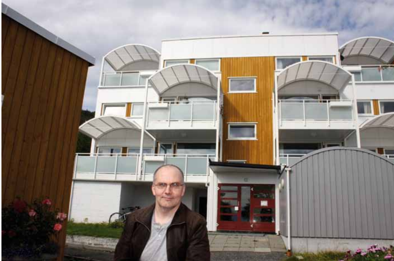
Styreleder Jan Husdal i Skrenten Borettslag er glad for at en stor rehabiliteringsjobb snart er ved veis ende.
