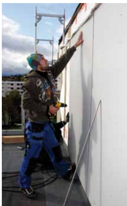
Arbeidet har pågått for fullt i høst.
