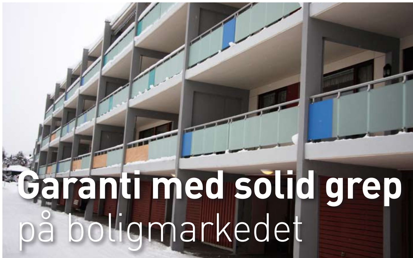
Garanti Eiendomsmegling er fortsatt den ledende megler i Molde. Bildet viser Øverland Borettslag.
