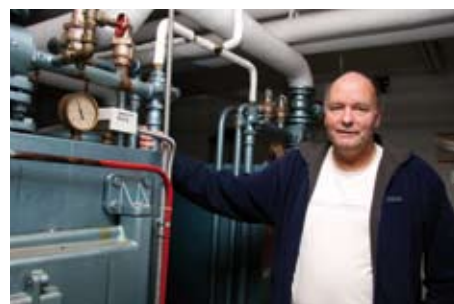
Generalforsamlingen vedtok utskifting av det gamle oljefyr-anlegget med varmepumpe og grunnboring.
