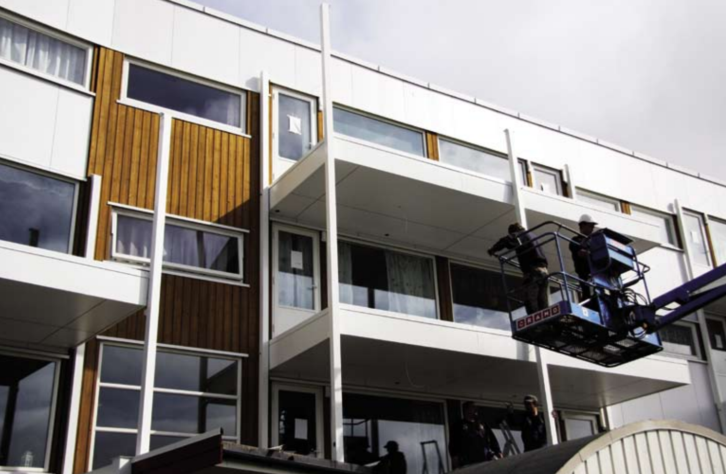
Her fra rehabiliteringen i Skrenten Borettslag.
