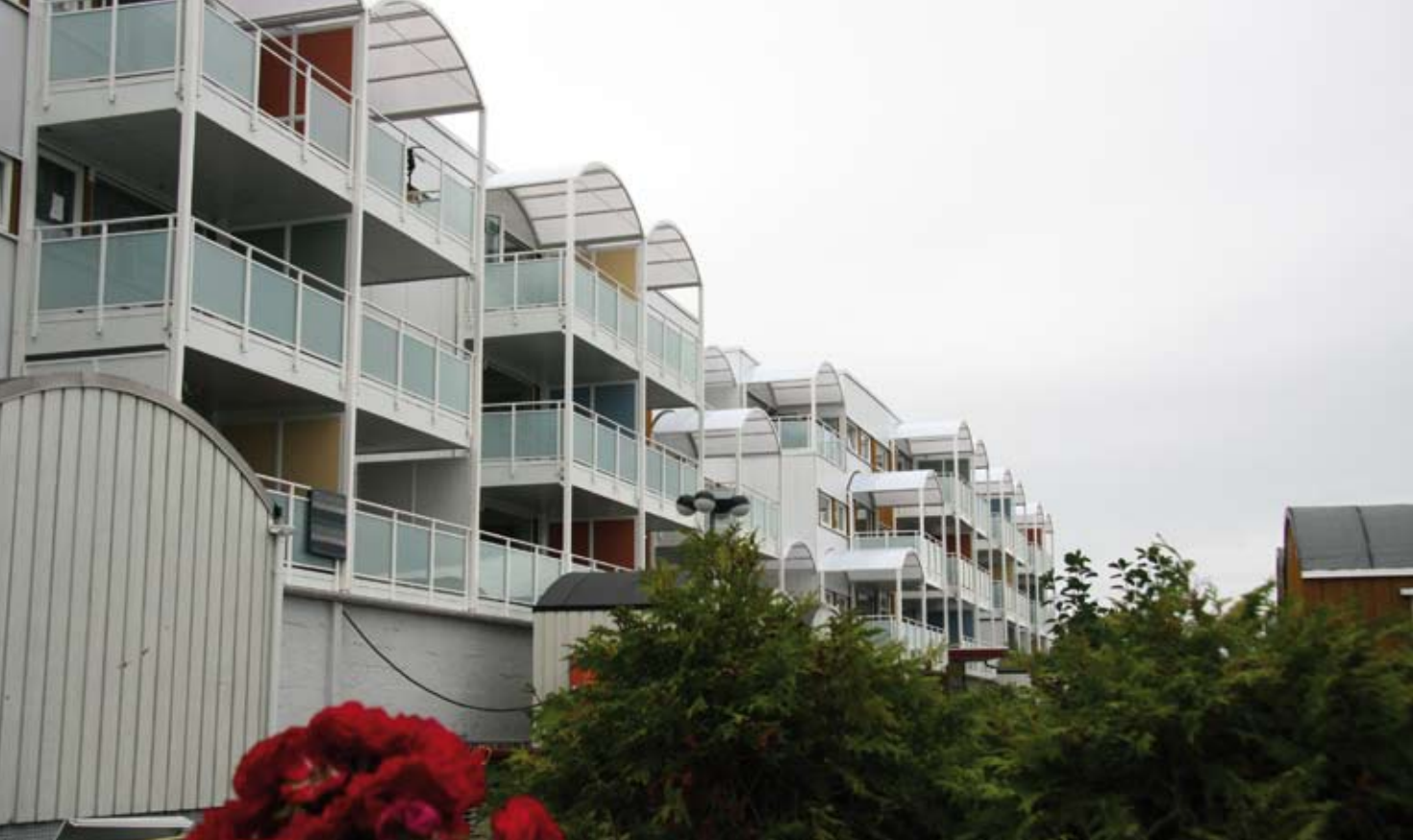
Skrenten Borettslag: Slik så det ut på nedsiden av den vestligste blokken ved inngangen til høsten.
