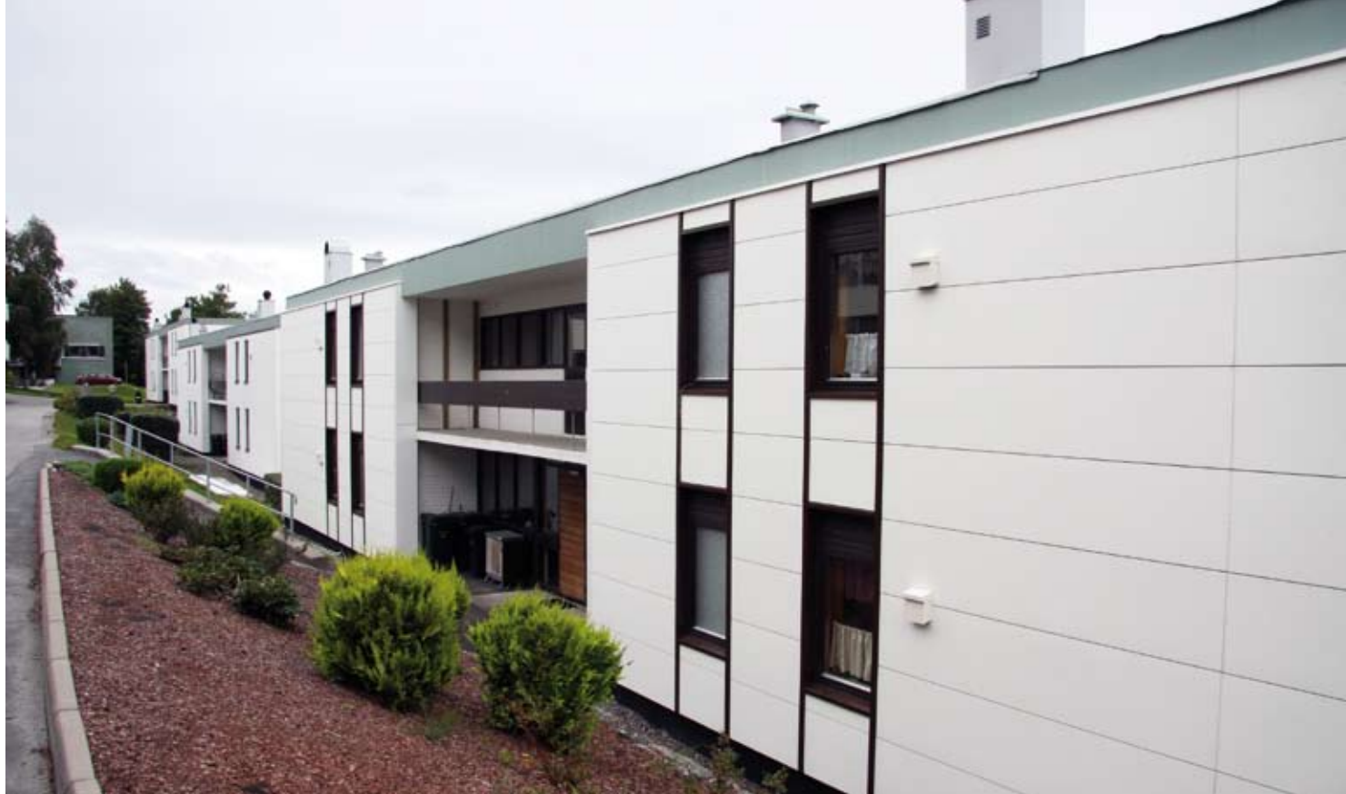
De første boligene har fått montert steniplater utenpå mursteinene i Lundabo Borettslag.
