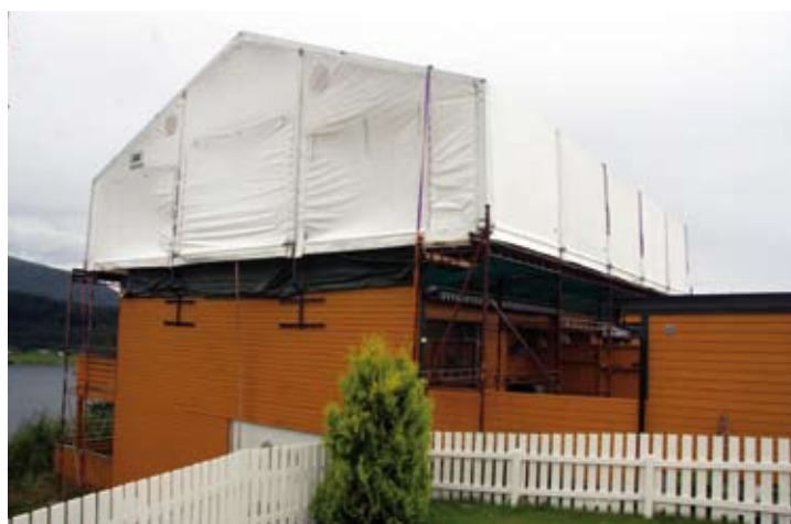
Slik ser tak-teltet i Opdølhaugen Borettslag ut fra utsiden.
