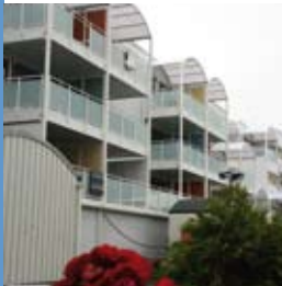
Mange MOBO-lag rehabiliterer s. 10
