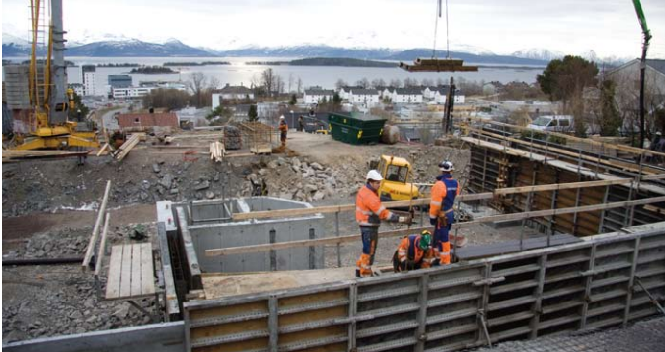
Byggearbeidet på den øverste boligblokken er godt i gang.
