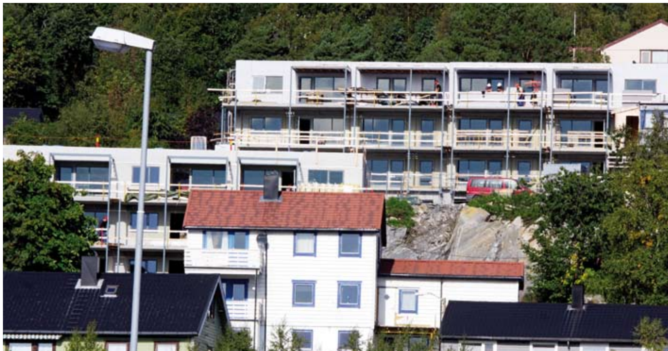
Boråsvegen Terrasse blir trolig utbygd med jordvarme og varmepumpe.
