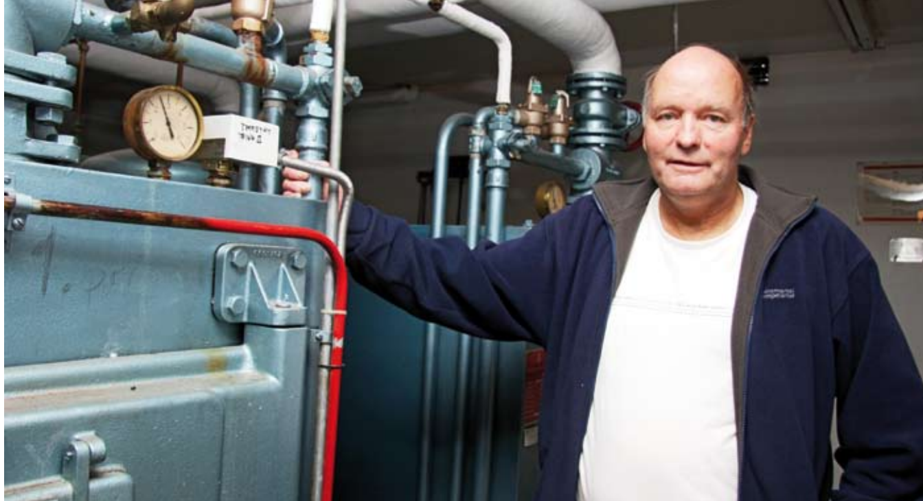
Styreleder Atle Vik i Bjørsetbo Borettslag foran dagens oljebaserte fyrkjel som gir varme i radiatorer og tappevarme til de 70 leilighetene i borettslaget, som består av tre blokker.
