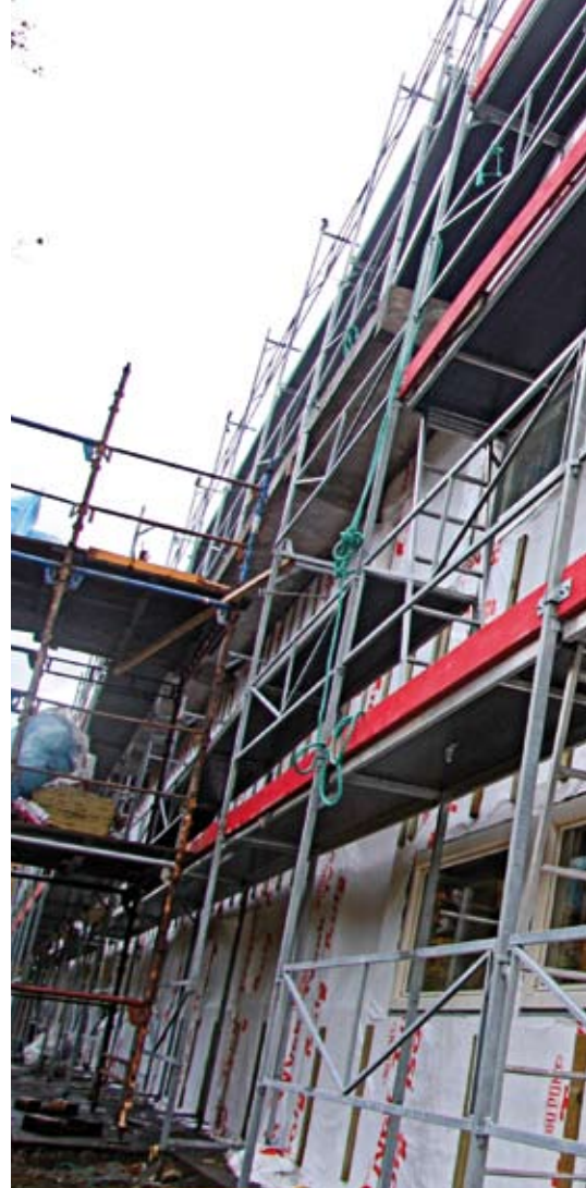
Rehabiliteringen av Skrenten Borettslag startet i august og vil pågå fram til høsten 2011.
