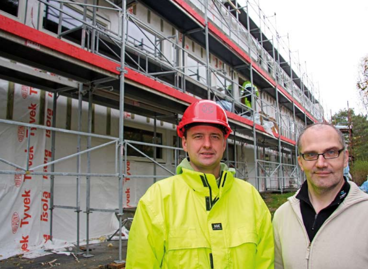
Styreleder Jan Husdal er glad for at beboerne viser stor tålmodighet under rehabiliteringsarbeidet. Her sammen med prosjektleder Lars Seljebø i Grytnes Entreprenør. Prosjektet er det største Sunndals-firmaet har hatt noen gang.
