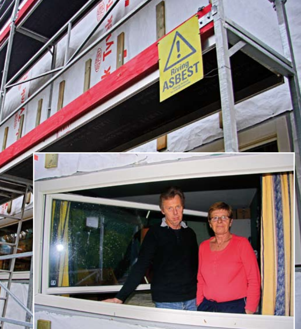
Åse Heggem og John Inge Sigersest kan glede seg over nye vinduer på nordsiden av leiligheten, men medgir at det var utfordrende å være uten fungerende ventilasjonsanlegg en periode som følge av rehabiliteringen.
