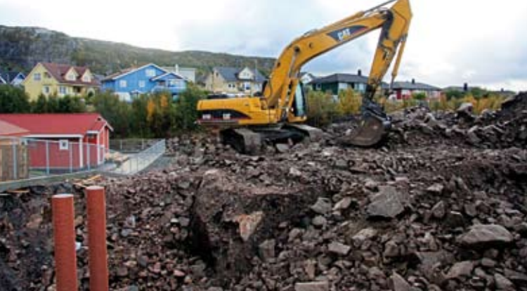
Anleggsmaskinene fra Storvik Maskin er allerede godt i gang på Draget.
