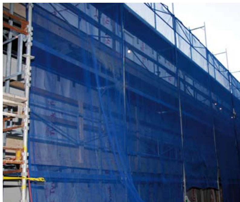
Skrenten Borettslag i gang med tidenes rehabilitering.
