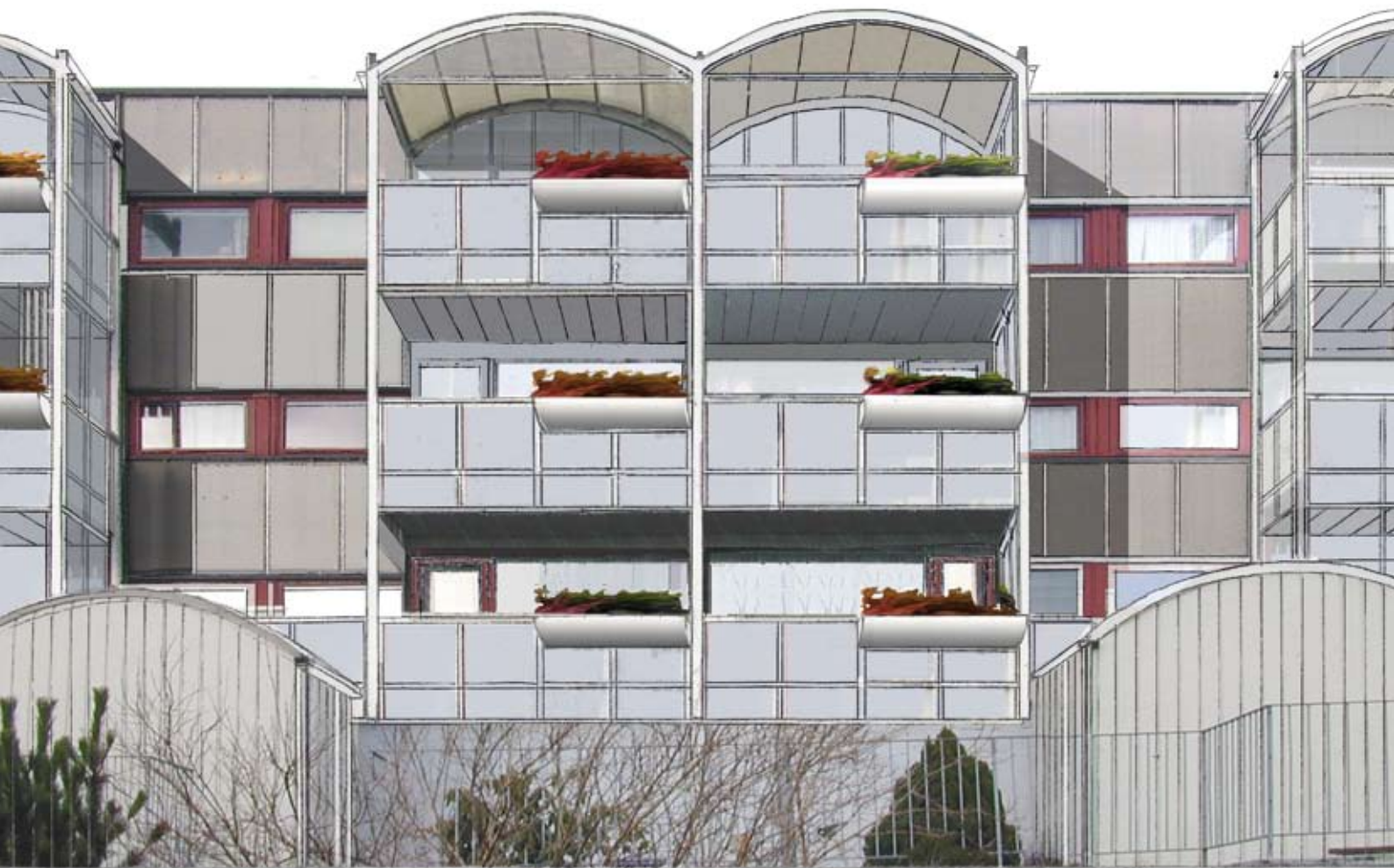
Slik ser sivilarkitekt Asbjørn Bua for seg fasaden etter rehabiliteringen av Skrenten borettslag, byens største borettslag.
