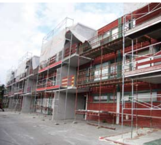
Rehabiliteringen av de siste blokkene (øverste) pågår i øyeblikket for fullt.
