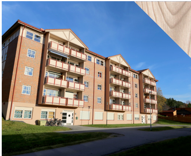
Stiftelsen Molde og Omegn Pensjonistboliger eier bygget i Mekvegen 13. De har bedt MOBO vurdere ombygging av ledig etasje til pensjonistleiligheter.
