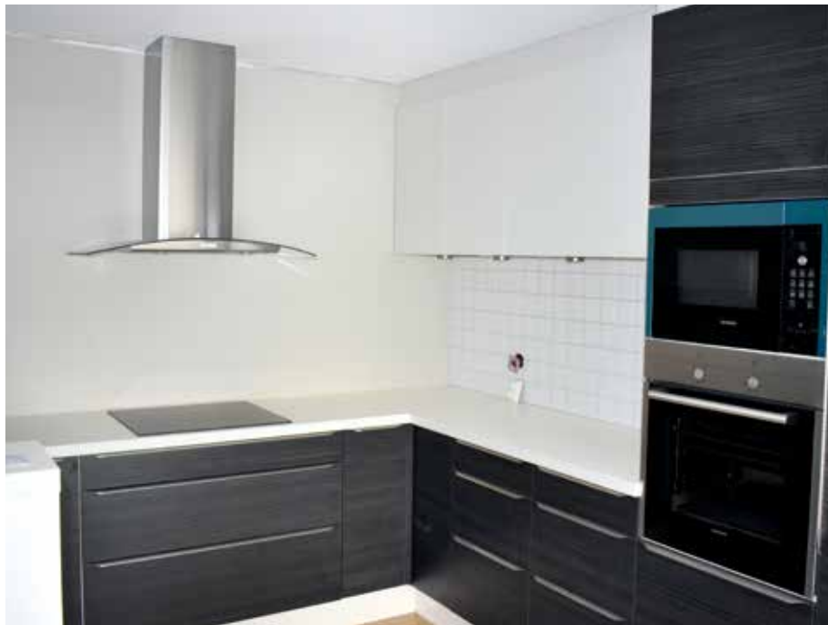
I mange leiligheter er kjøkken nå snart ferdig montert.
