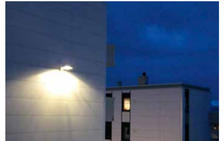
Samtidig med fasadearbeidet ble utvendig belysning forbedret.
