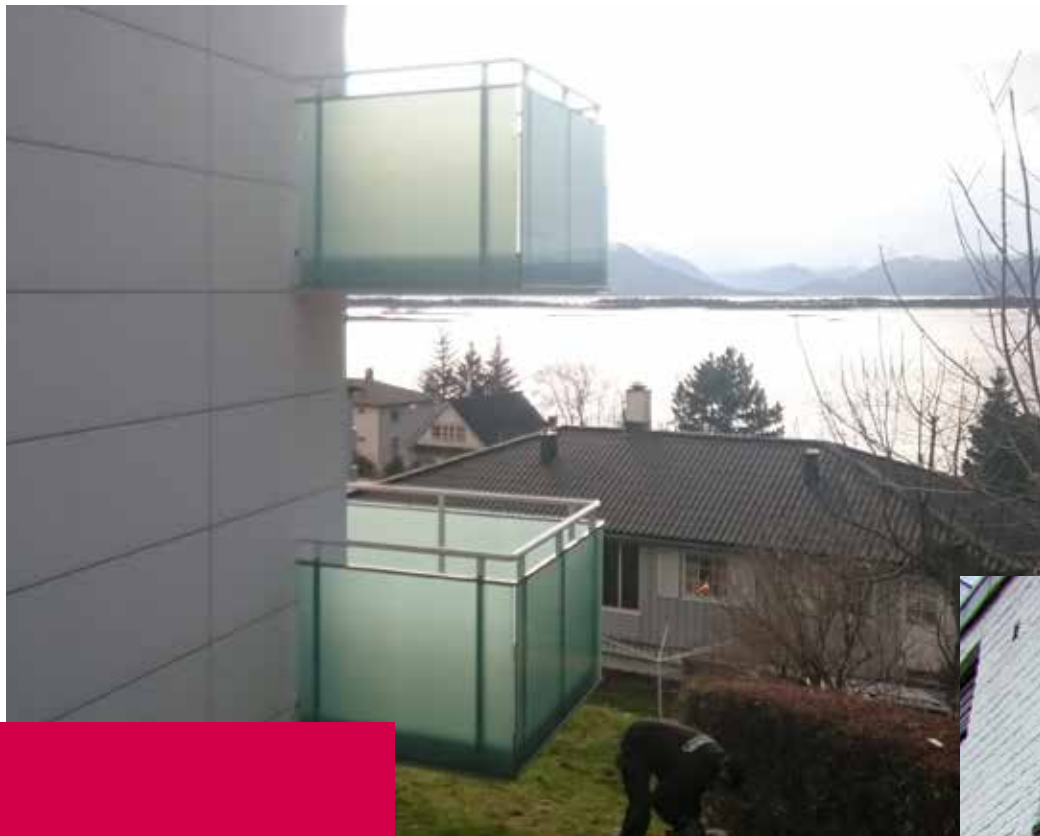
Fasaden ble platekledd for å forlenge intervallene for vedlikehold. Gammel fasade under, ny til venstre.
