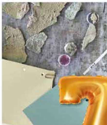
▲ Lag på lag med gammel maling ble fjernet for å finne tilbake til det opprinnelige.
