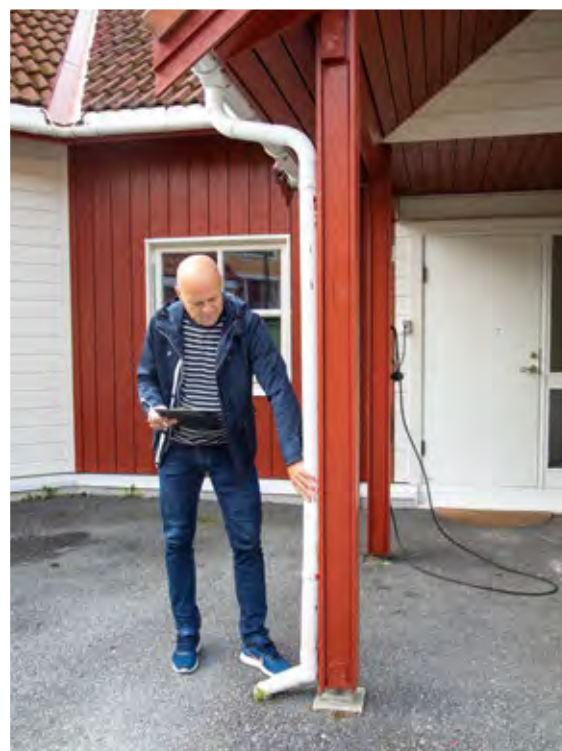
▲ Sjekking av takrenner og det ytre skallet høres med når tilstanden sjekkes.
