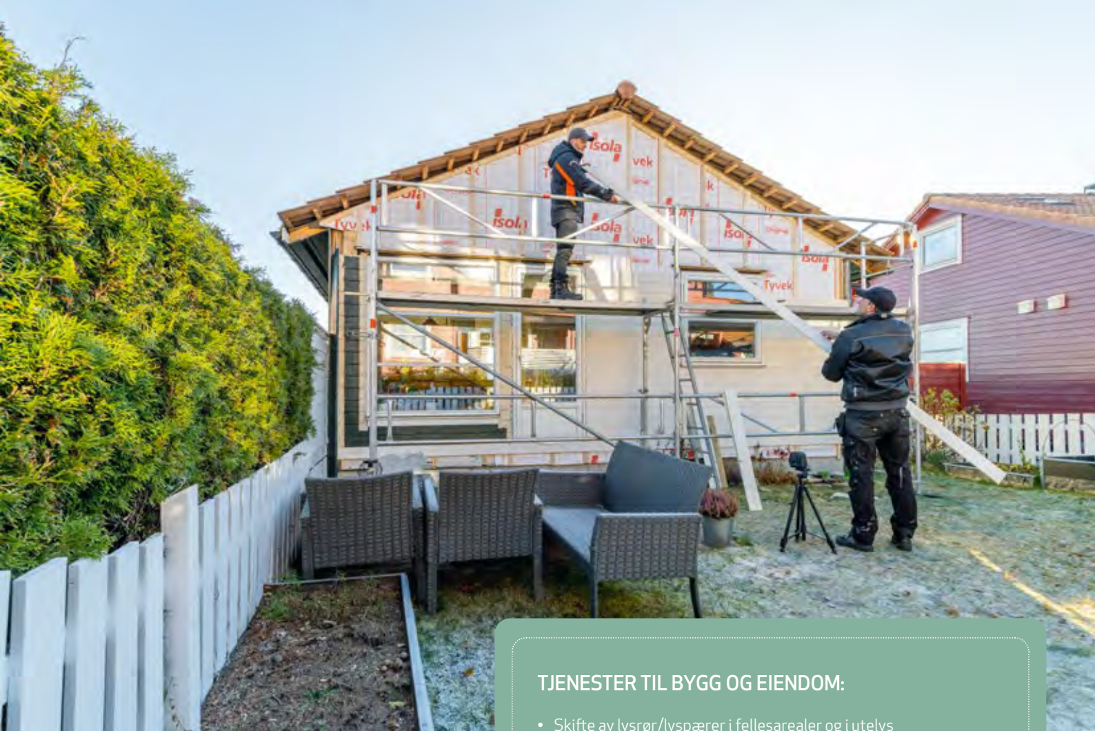
▲ Mårskrenten Borettslag i Nordbyen benytter MOBO Eiendomsservice til ytre vedlikehold. Her er Vegard og Bjørn Are Høstmark i full sving med å legge ny bordkledning på ett av byggene.
